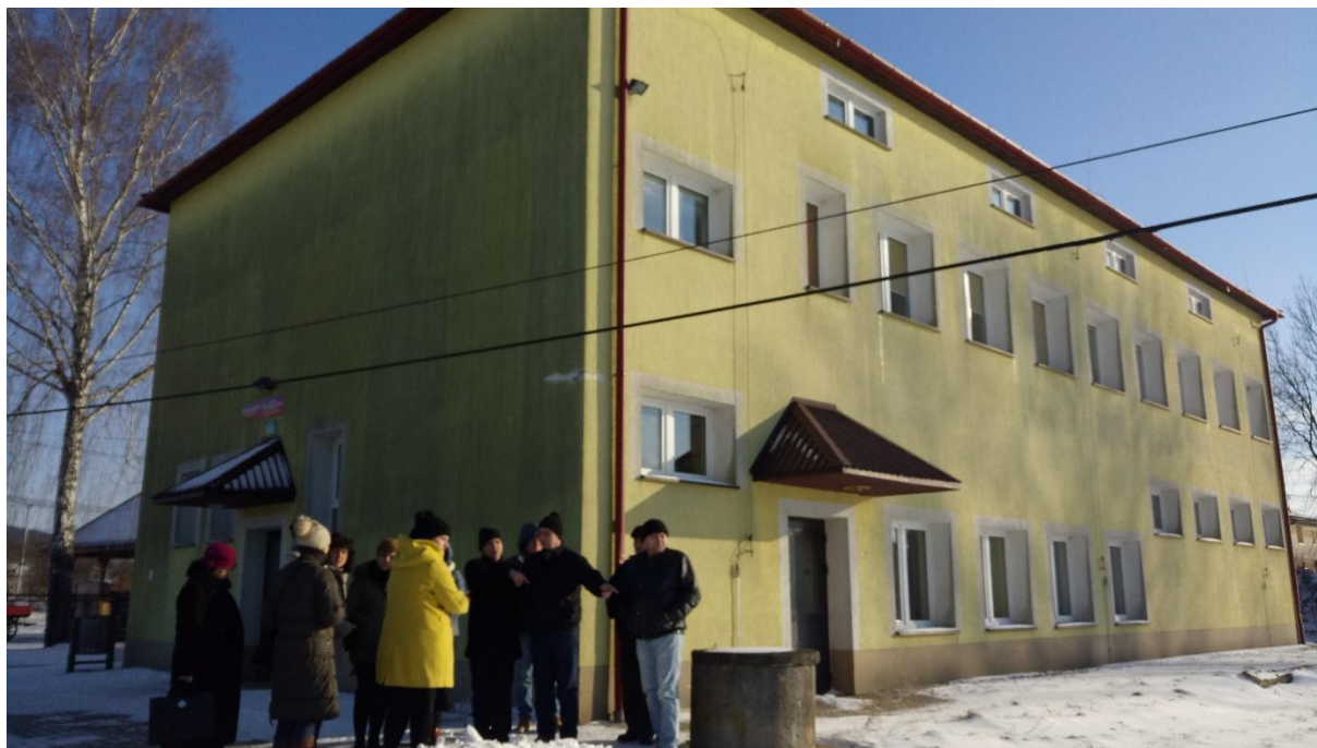
Rysunek 22. Budynek wiejski – stan obecny
